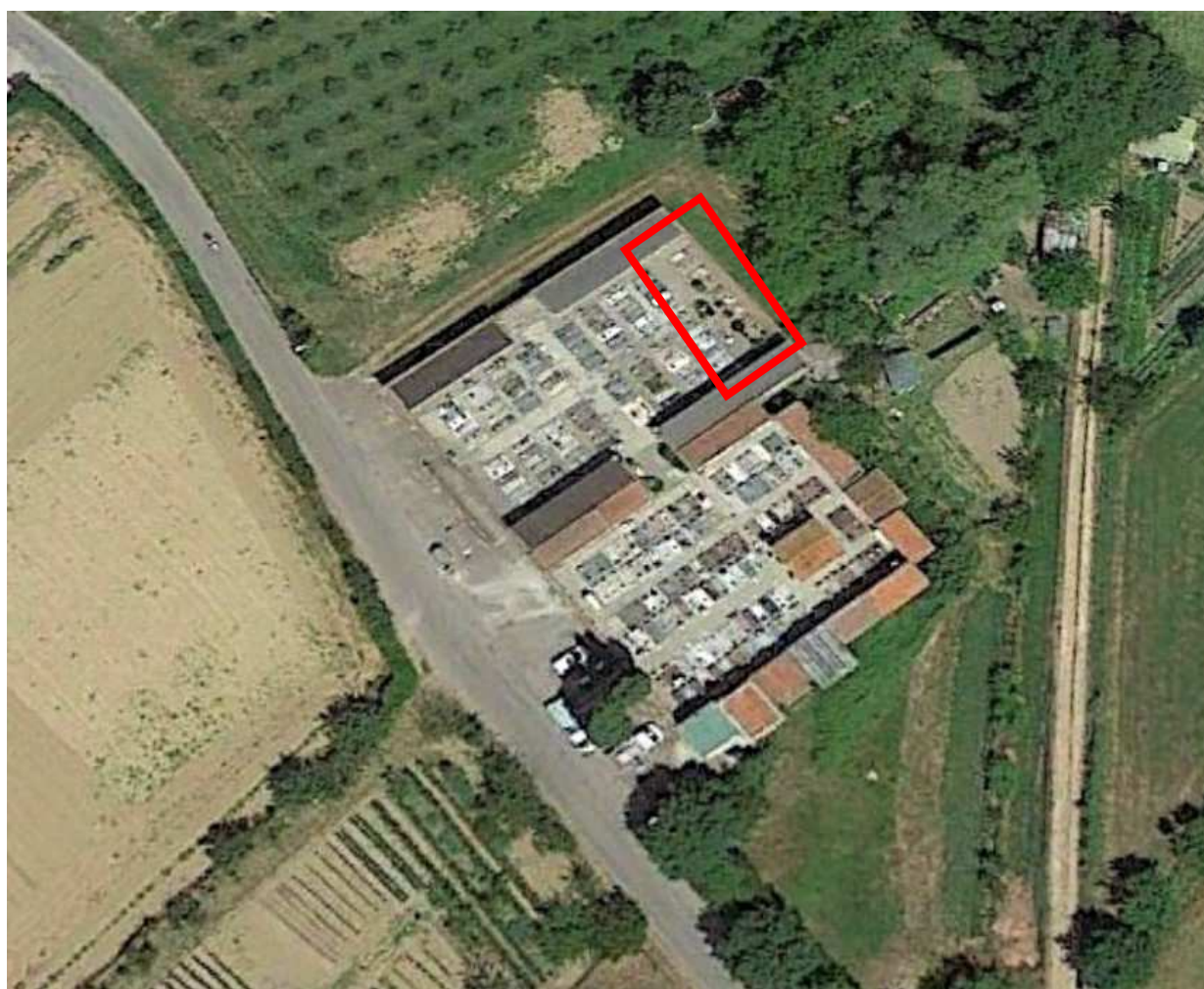
Foto zenitale dell'area oggetto d'intervento
